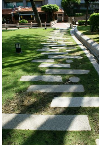
圖 5 鋪面不連續、不平整，易發生意外 資料來源：作者拍攝，2012 年 6 月
