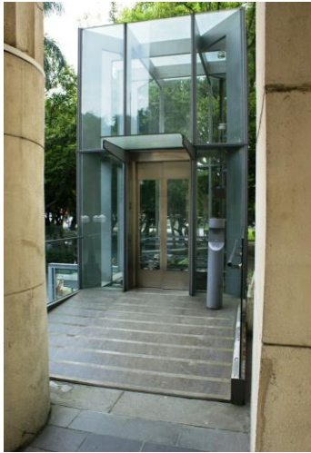
圖 4 升降機銜接入口的平台坡度大於 1/50 資料來源：作者拍攝，2012 年 6 月
