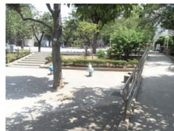
無段差具充分寬幅的園路
